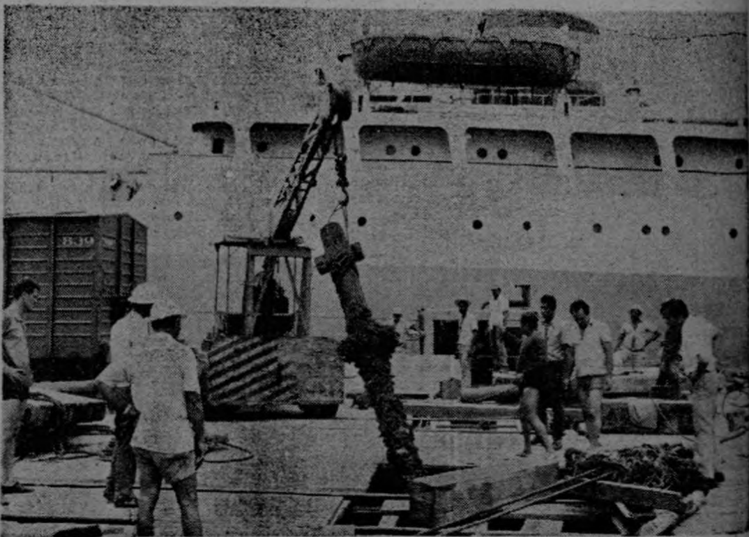
Uno de los pilotes herrumbrosos es sacado del fondo del mar para sustituirlo por otro nuevo. Al lado derecho de la gráfica aparece dirigiendo las labores el Sr. John Mann, técnico en esas labores y el Jefe de Relaciones Públicas del INCOP, Sr. Alvaro Alvarado.
